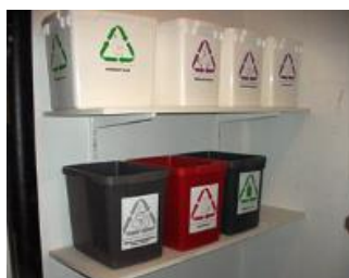
Återvinningsstation kulvert med sorteringskärl
