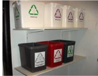
Återvinningsstation kulvert med sorteringskärl
